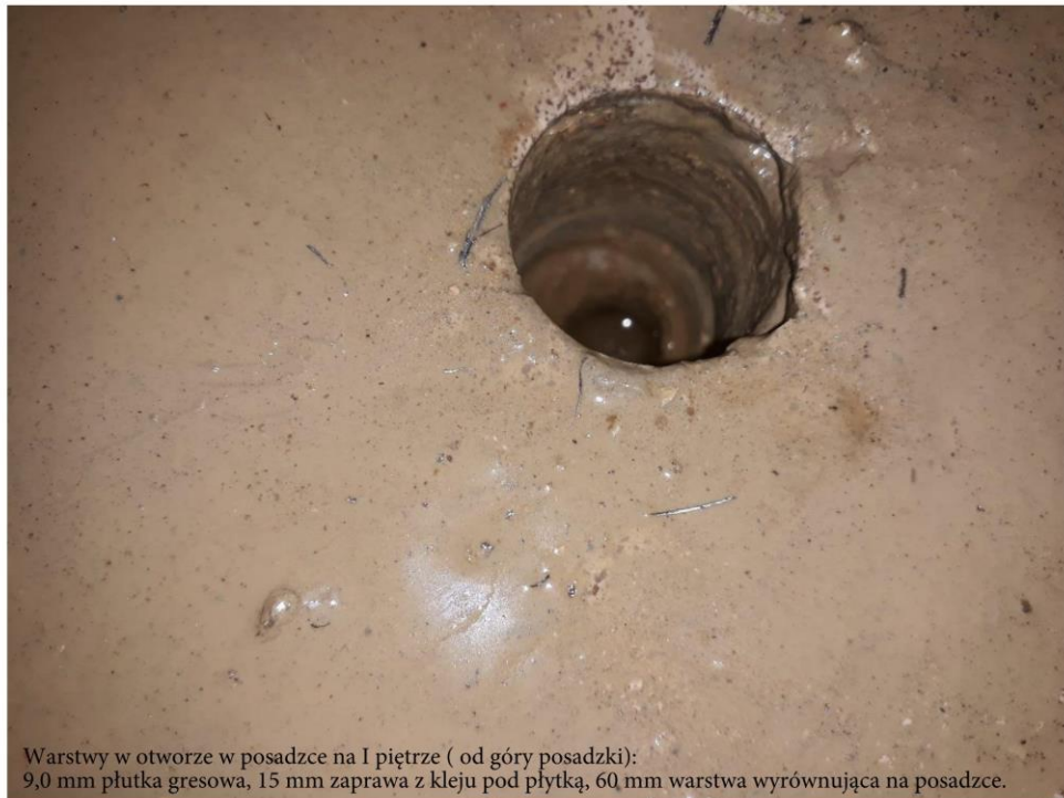
Zdjęcie nr 5 Odkrywką posadzki na I piętrze.
