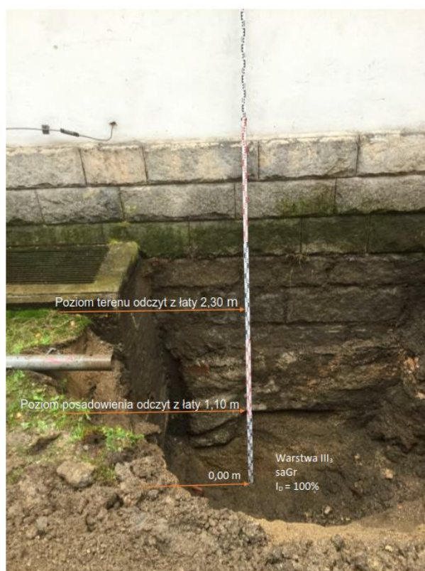
Zdjęcie nr 1. Odkrycie fundamentu. W poziomie posadowienia znajduje się zwietrzały granit saGr.
